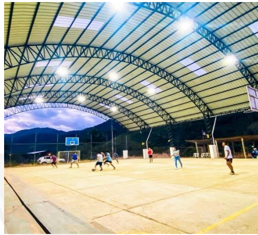
Iluminación de canchas
